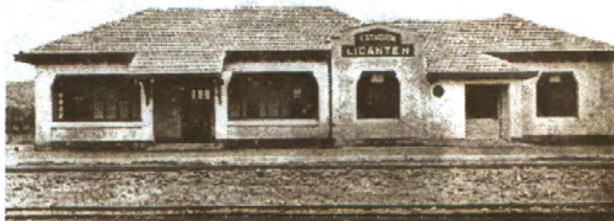
Edificio de la estación Lican- ten durante la construcción del ramal.
